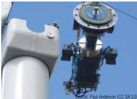
이 12톤 중량의 초대형 변속기와 디스크 브레이크는 크레인으로 60m 높이에 있는 풍력발전기에 설치된다.
